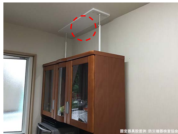
突っ張り式固定器具 (取付後)
