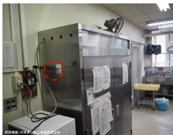
バンド式粘着固定器具(取付後)
