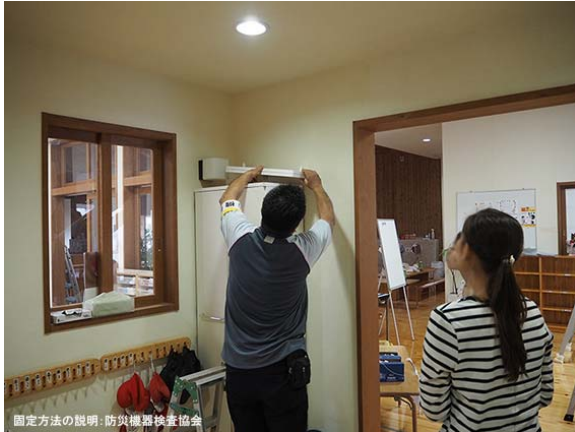
突っ張り式固定器具の取付方法
